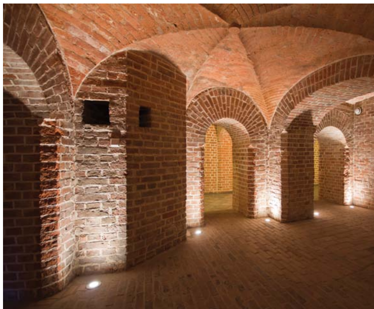
→ Sklepienia w piwnicach redity
